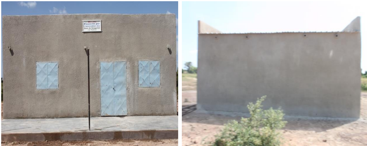
Installation du moulin de Bagma
